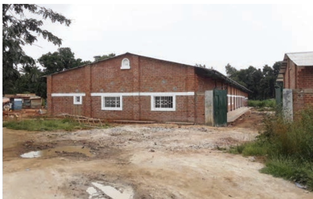
Nueva edificación en curso
